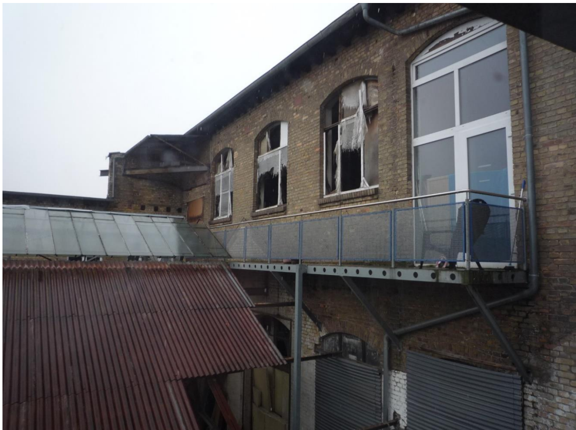
Foto 3 Firmengebäude vom Innenhof aus – Abriss geplant
