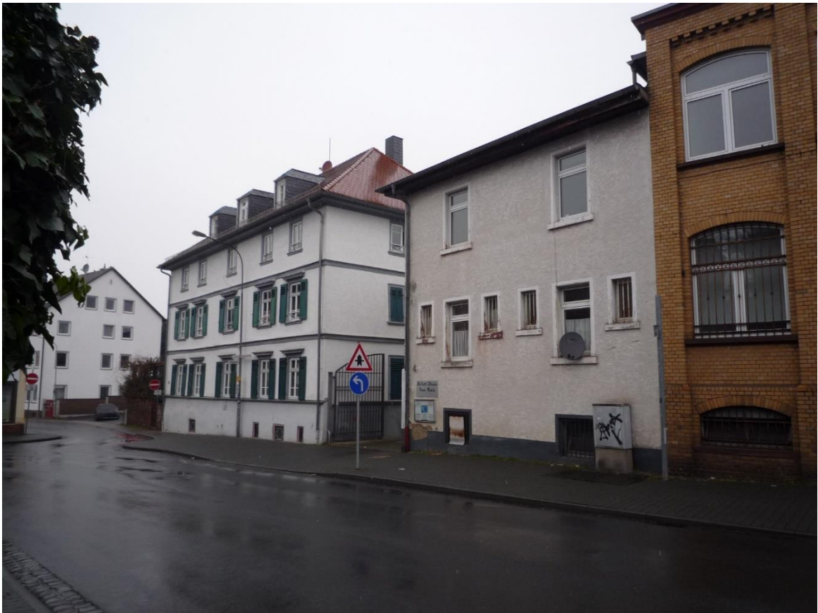
Foto 2 Abrissgebäude am Wilhelm-Leuschner-Platz – Flachdachgebäude in der Mitte
