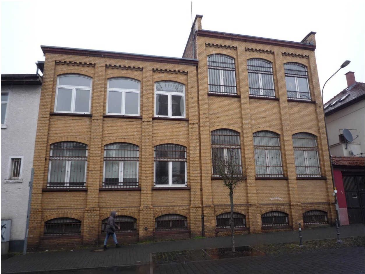
Foto 1 Genutztes Flachdachgebäude am Wilhelm-Leuschner-Platz
