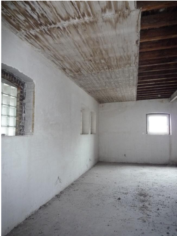
Foto 8 Abgehängte Decke
