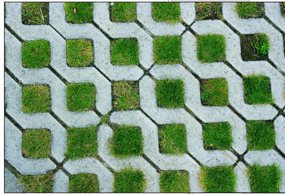
Beispiel wasserdurchlässige Befestigung
