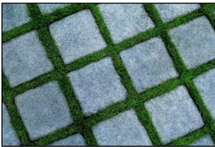
Abbildung 4 Beispiel wasserdurchlässige Befestigung, Rasenfugenpflaster
