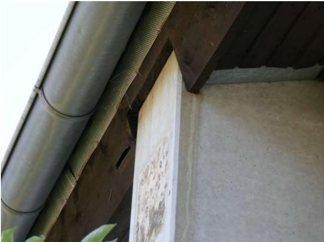
**Abb. 6:** Sehring-Halle, Insektenschutzgitter und Spalträume unter der Dachrinne
