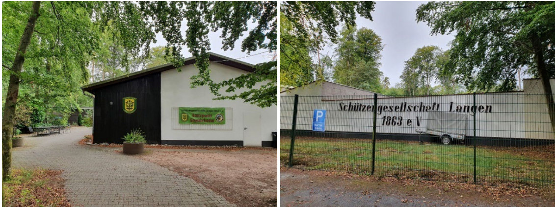
Abbildung 16: Schießanlage der Schützengesellschaft Langen 1863 e.V. südwestlich des Plangebietes (Quelle: Eigene Aufnahme Planergruppe ROB GmbH)
