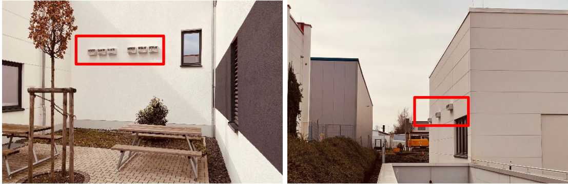
Abbildung 18: Fotodokumentation der umgesetzten Maßnahme
