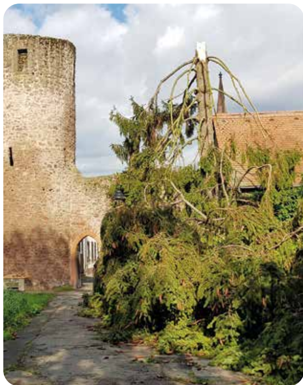
Sturmschaden: Abgeknickter Nadelbaum am Stumpfen Turm
